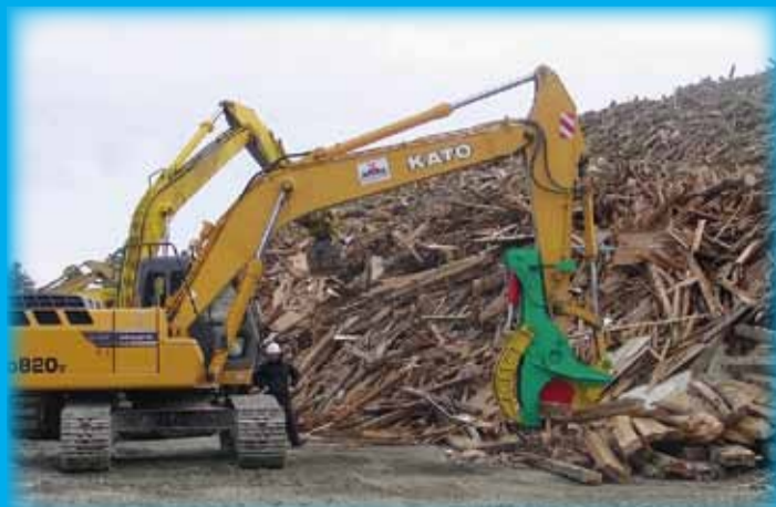
H24.1 福島県 福島震災現場
