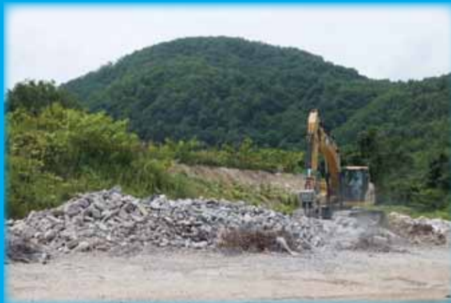
H24.7 北海道 古平小学校解体工事
