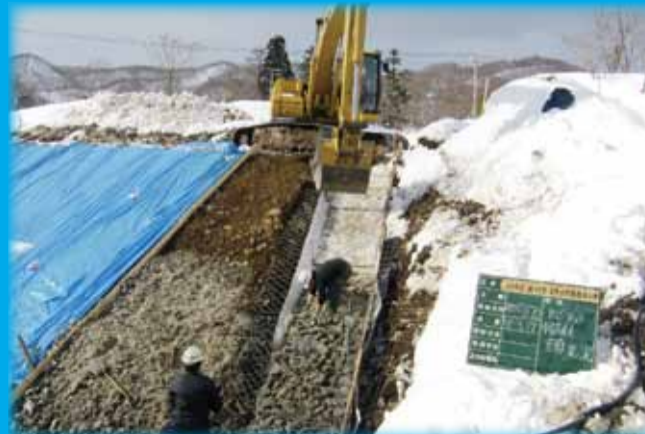
H23.3 北海道 22年災古平川災害復旧工事
