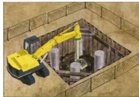
建築基礎根切り作業
