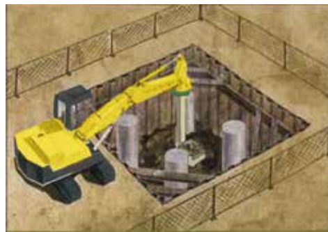
建築基礎根切り作業
